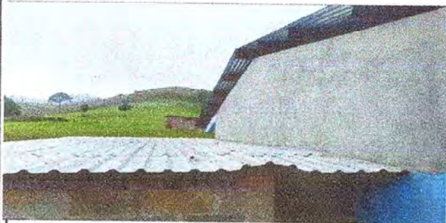
No.9 sustitución de repello por deterioro de pared
