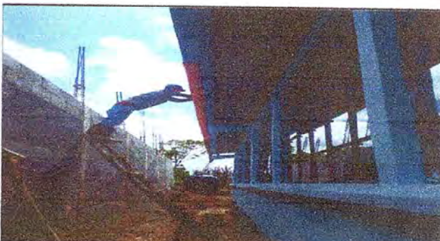
SUSTITUCION DE TUBOS FLUBIALES
