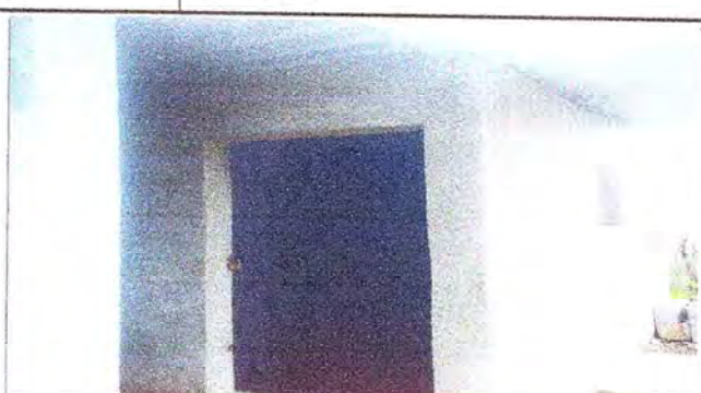
SUSTITUCION DE PUERTAS DE BAÑO
