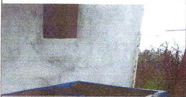
SUSTITUCIÓN DE VENTANA DE BODEGA
