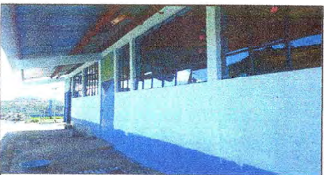
SUSTITUCION DE PINTURA INTERIOR EXTERIOR
