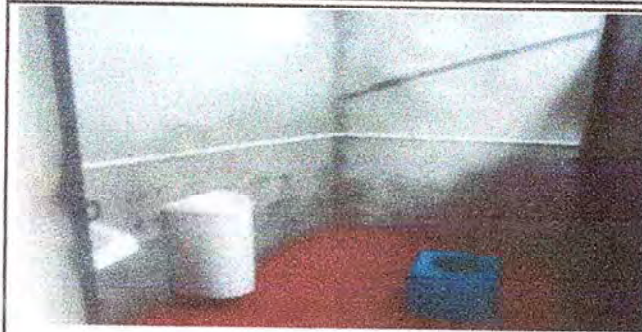
No. 7 sustitución de baños por deterioro
